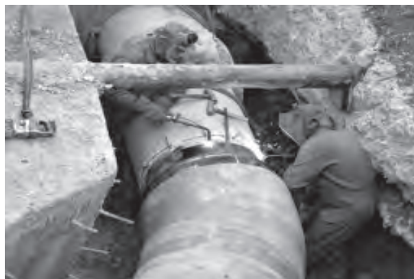
Figura 1. Trabajo en zanjas grandes
