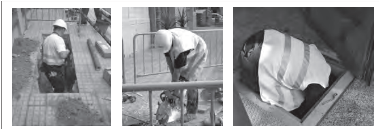
Figura. 3. Trabajo en zanjas pequeñas
