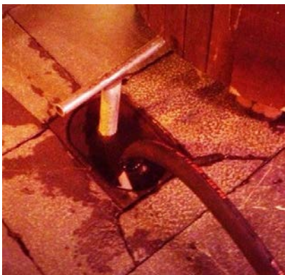
Boca de riego y baldeo manual.
